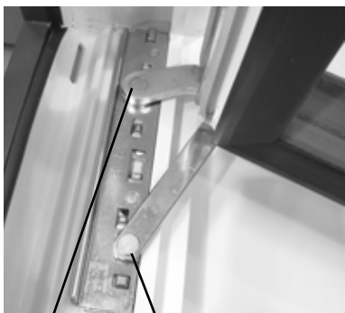
1 2 Dolní rohová ložiska
